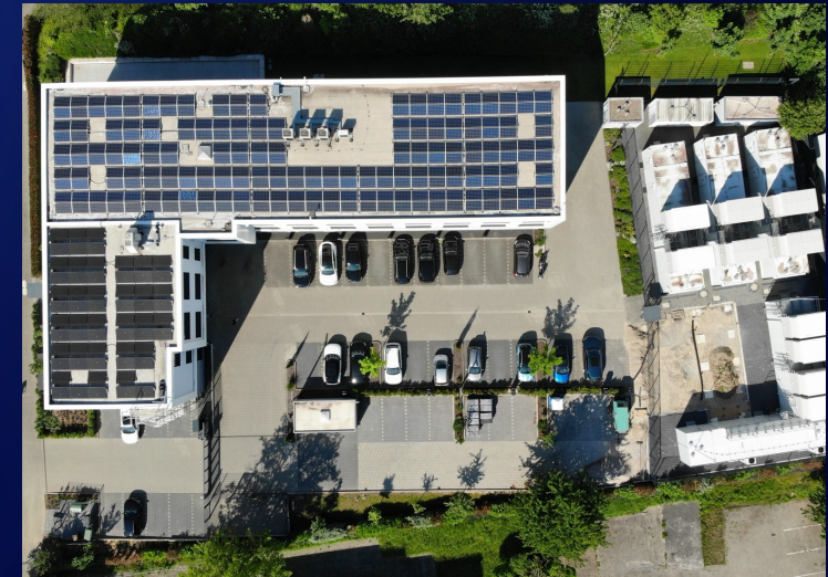
synaforce Standort Mainz Modularen Data Center (MDC)
